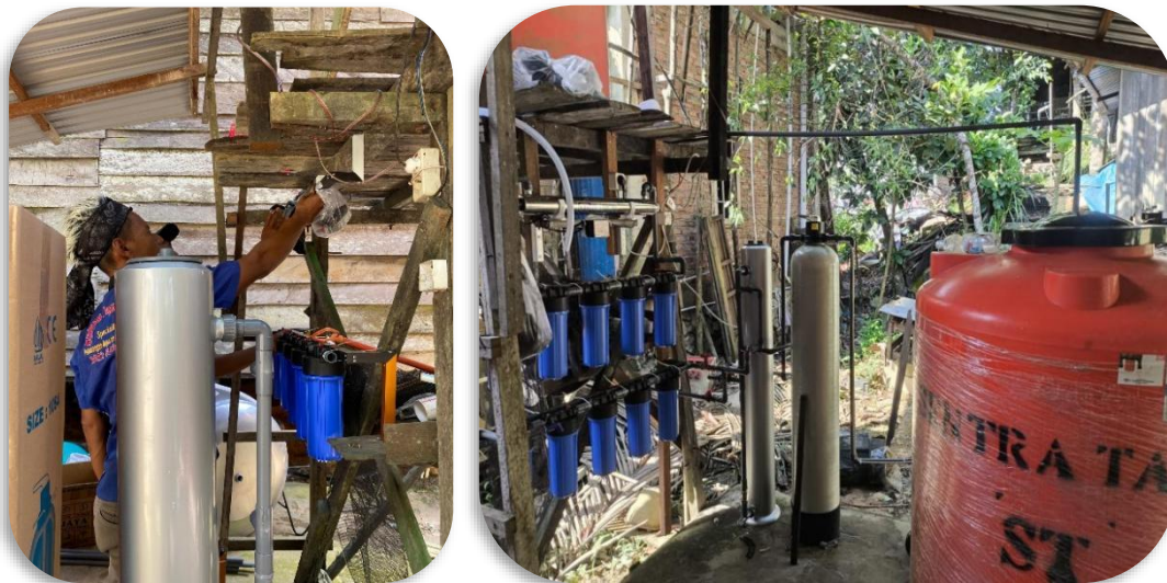
Gambar 3. Proses Pemasangan Alat Filtrasi
