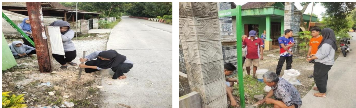
Gambar 6. Pembuatan dan Pemasangan Papan Nama Jalan
